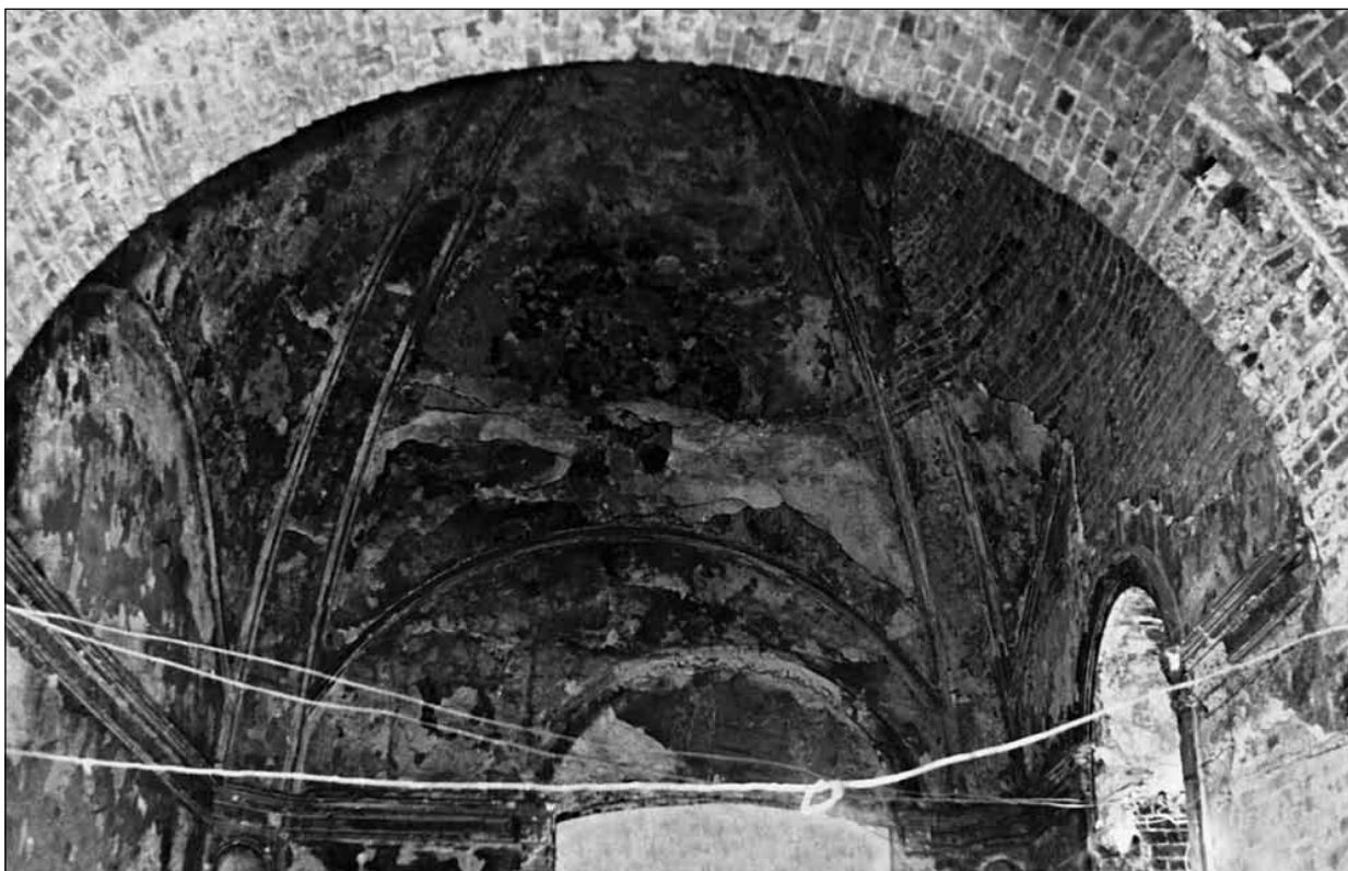
Внутренний вид полуразрушенного храма
