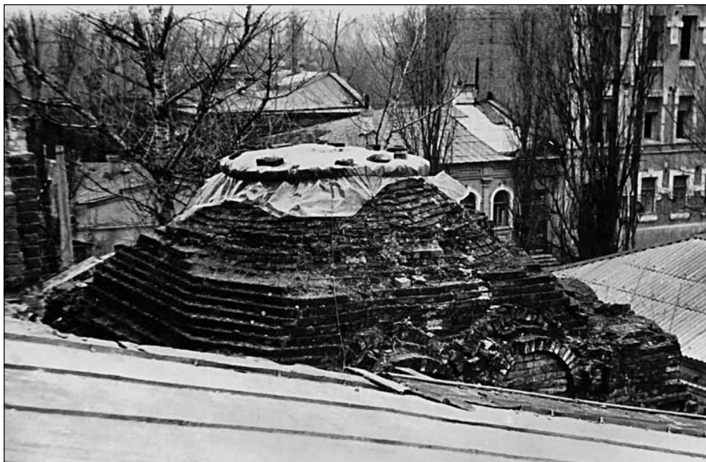
Внешний вид полуразрушенного храма
